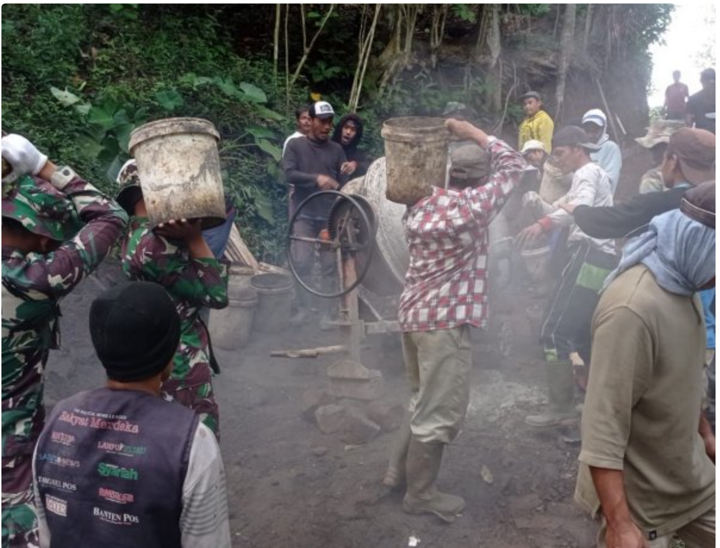
Pelansiran Matrial di Lokasi TMMD
